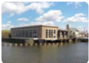
手賀排水機場(左)と千葉県手賀沼土地改良区事務所
