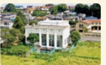
4 都部新田揚水機場 (高野山(滝下)揚水機場から名称変更) 【撤去更新】地盤沈下や土砂堆積のため、揚水ポンプを改修。
