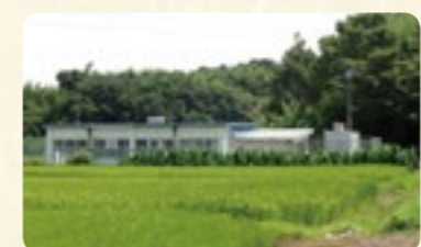
5 小森揚水機場 【撤去更新】地盤沈下や土砂堆積のため、揚水ポンプを改修。
