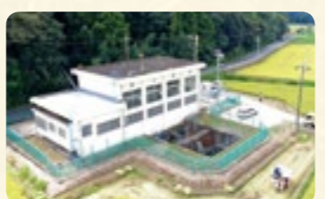
3 泉揚水機場 【撤去更新】地盤沈下のため、用水ポンプを改修。
