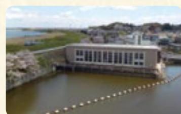
1 手賀排水機場 【撤去更新】排水ポンプの能力を増強。 〈排水量〉40m 3 /s → 62m 3 /s
