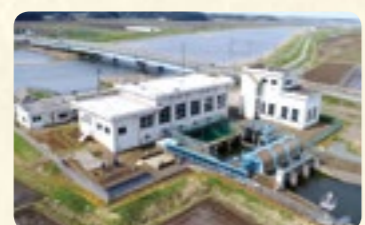
2 手賀第二排水機場 【撤去更新】地盤沈下のため、排水ポンプを改修。
