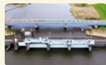
7 手賀沼調節水門 【撤去】手賀排水機場へ機能の代替を行なうため撤去。
