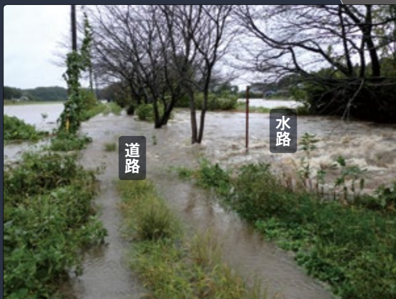
金山落水路の湛水状況
